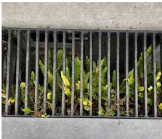
Tong- en steenbreekvarens in een keldergat aan Trans.
